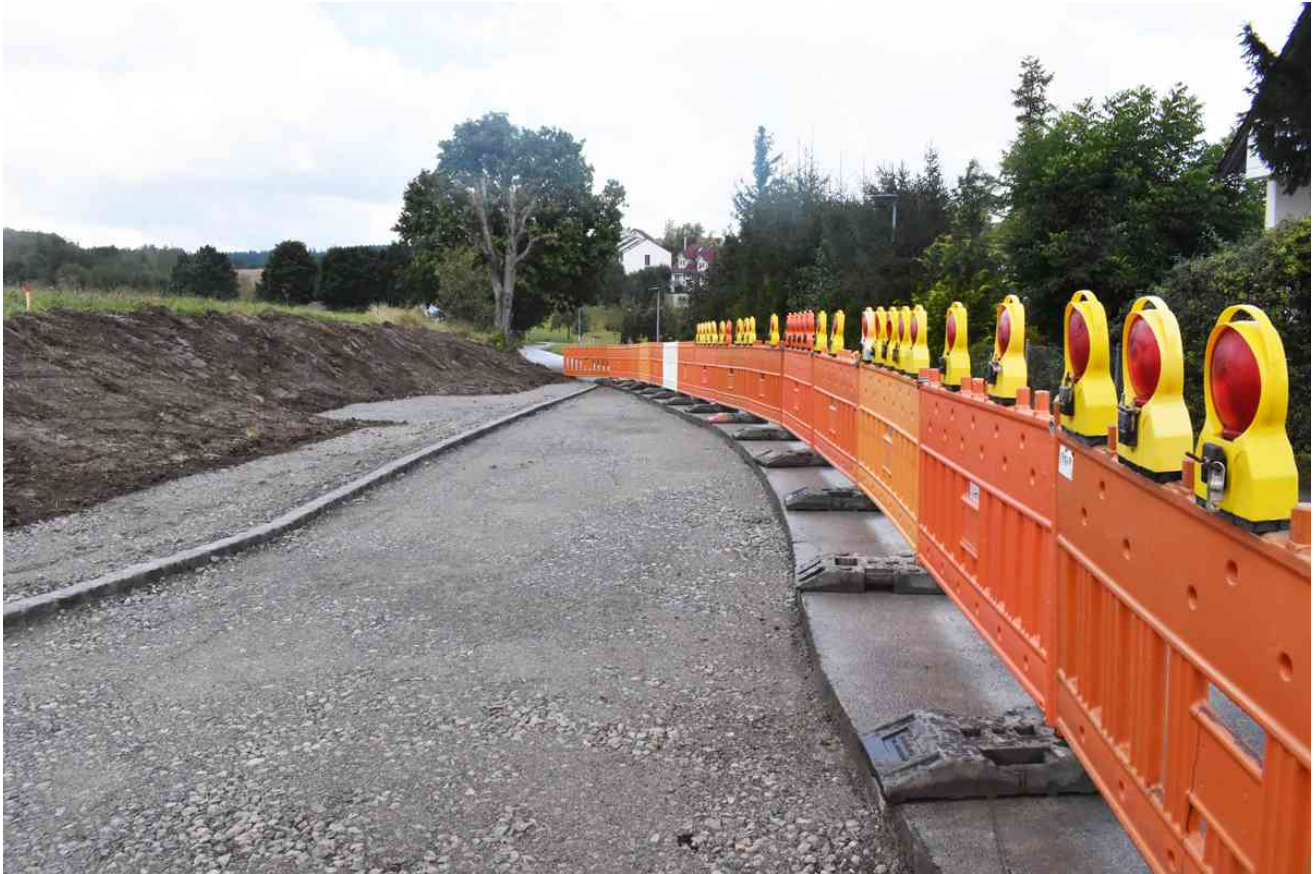
Die Arbeiten zur Verbreiterung der Brückengasse haben begonnen – hier bei der Abzweigung Uhlandstraße.
