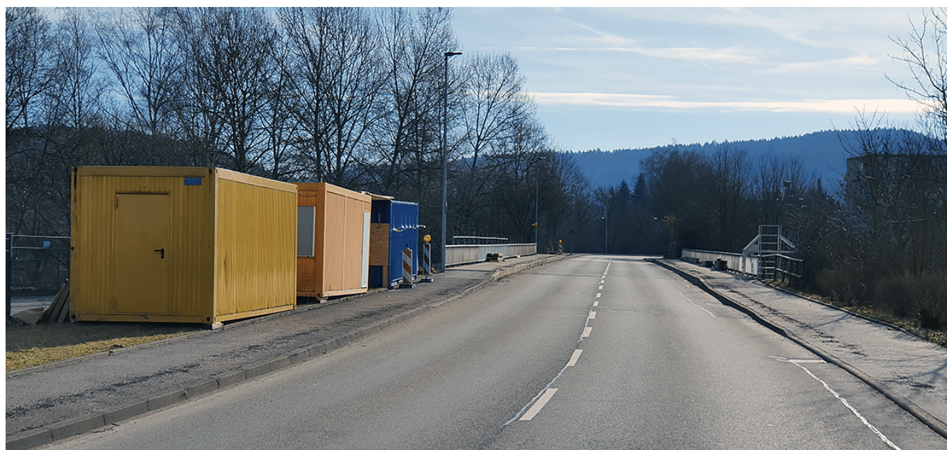
Baustelle ist vorbereitet: Lehrstraße wird im Bereich der Neckarbrücke ab Montag gesperrt.
