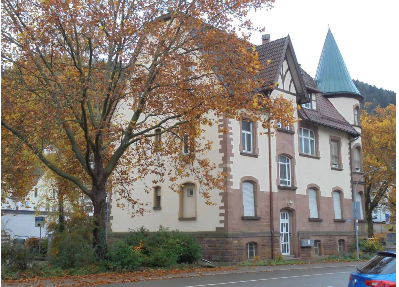
Für die Barrierefreiheit müsste die Stadt einen Aufzug auf der Gebäuderückseite anbauen lassen. Foto: him
