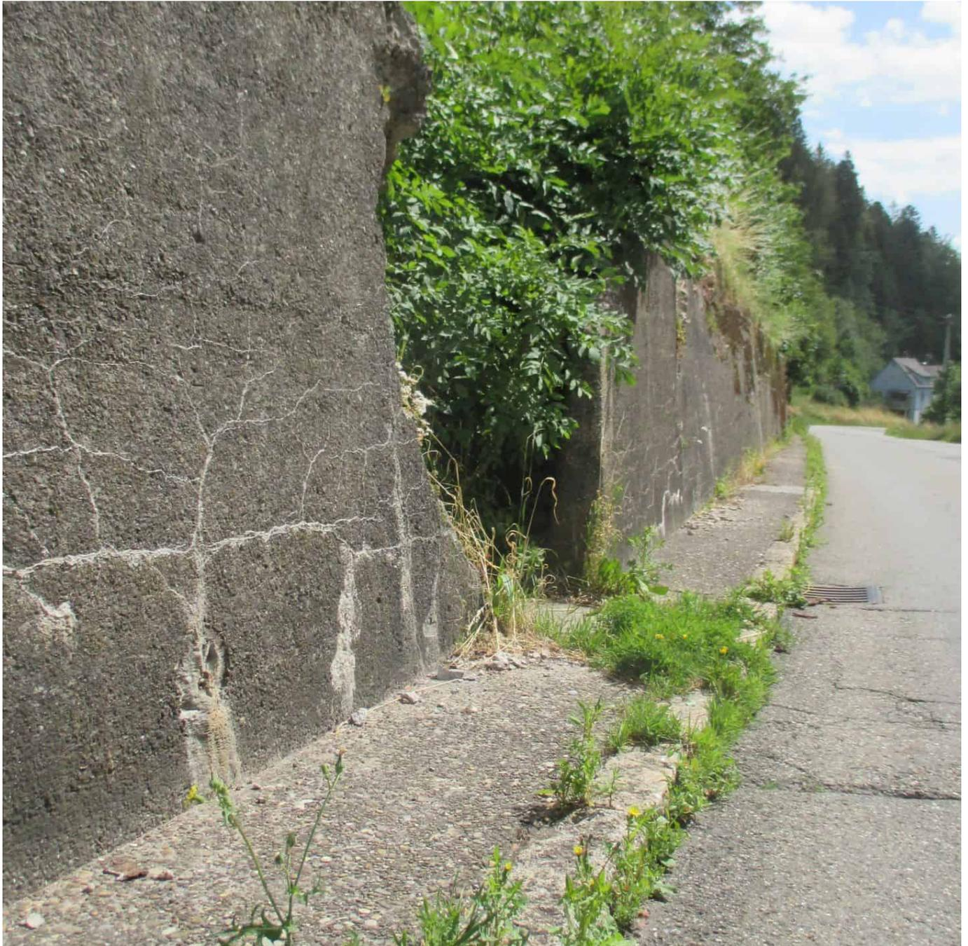
*Schwere Schäden an der alten Betonmauer.*
