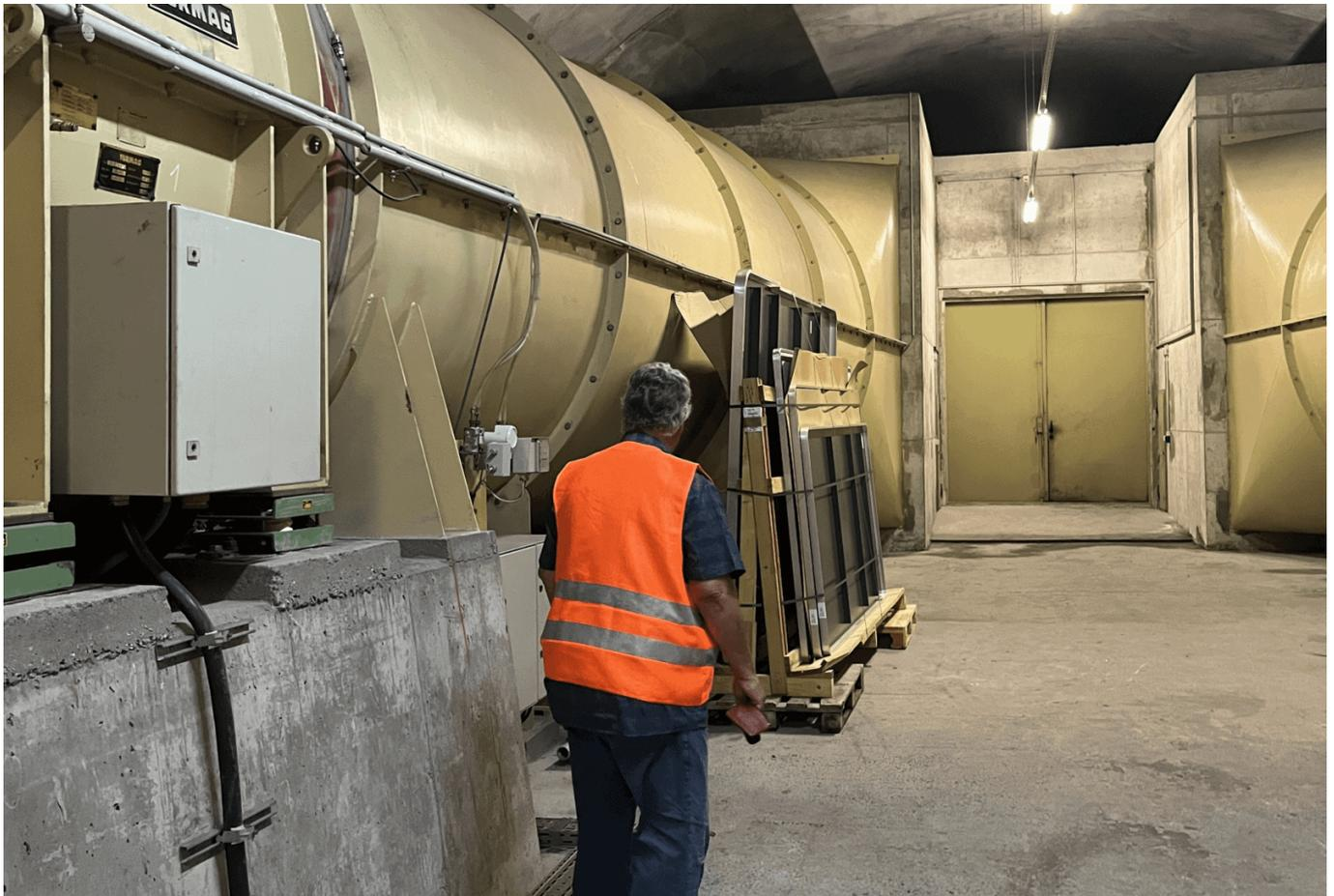
*Blick in die Abluftanlage des Tunnels, wo im Ernstfall die Entlüftung beziehungsweise die Entrauchung erfolgt.*
