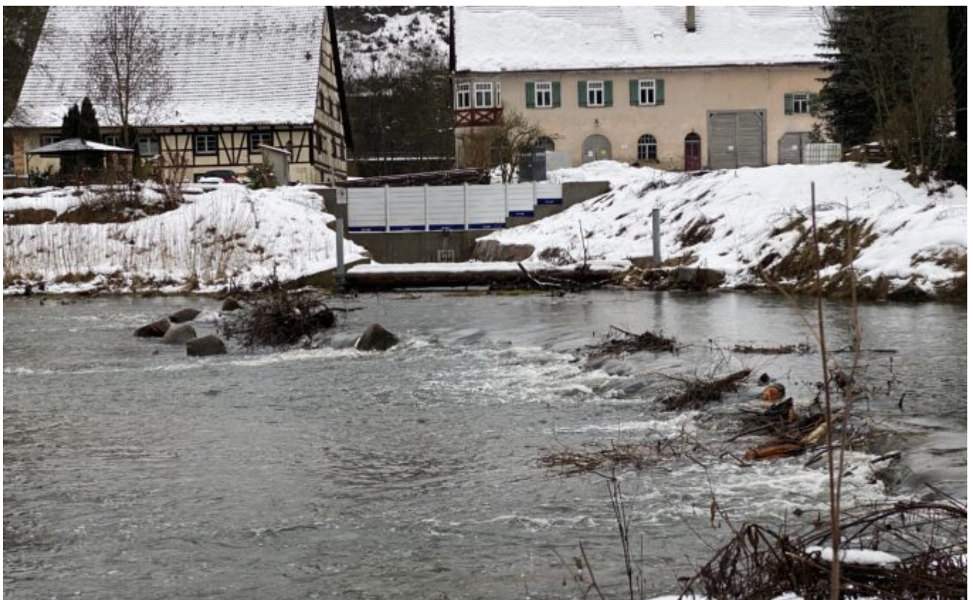
Bereits gesetzt: Hochwasserschutz am Neckar.
