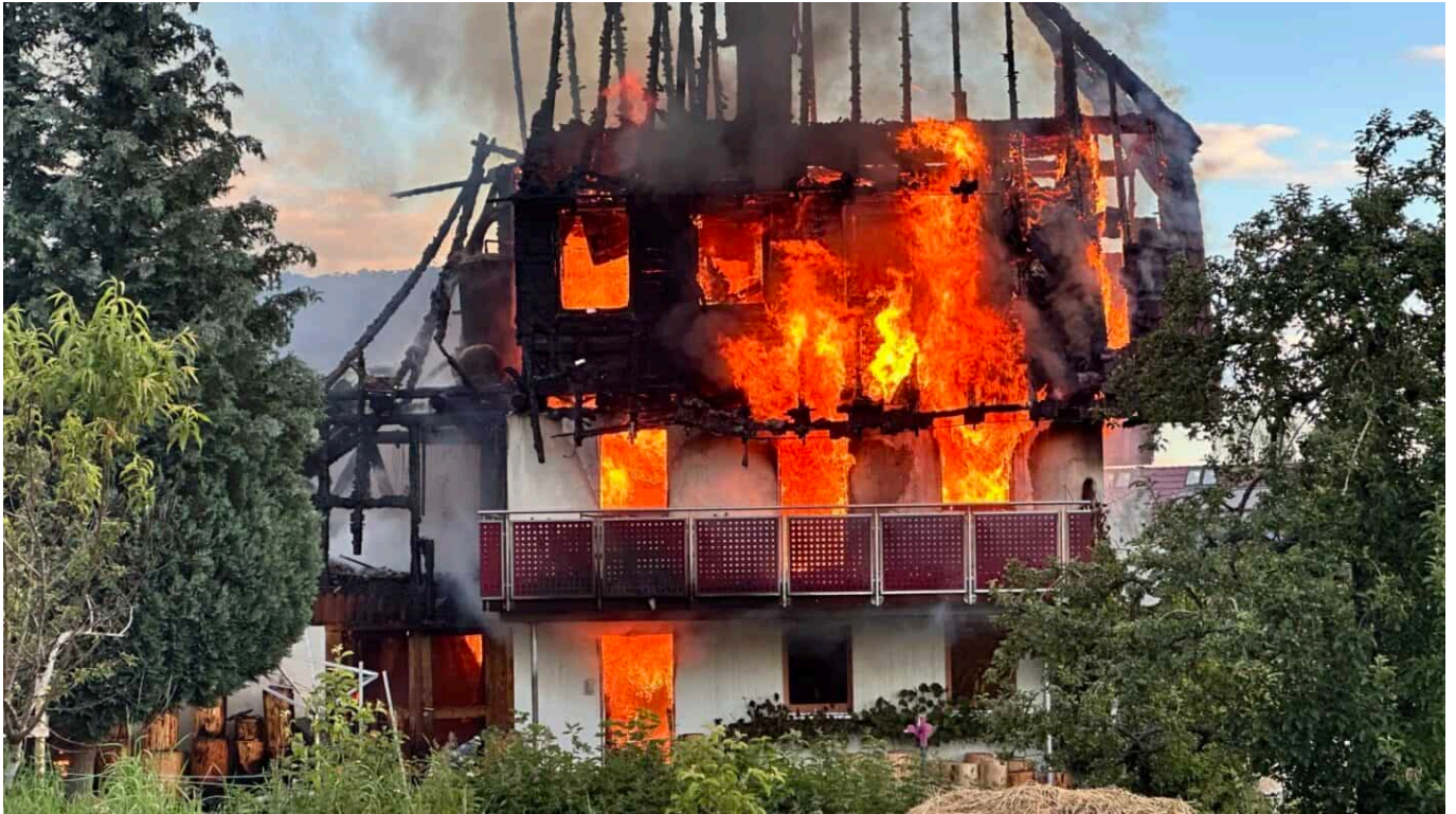
Nicht zu retten: das Gebäude in Hardt brannte vollständig aus. Foto: gg
