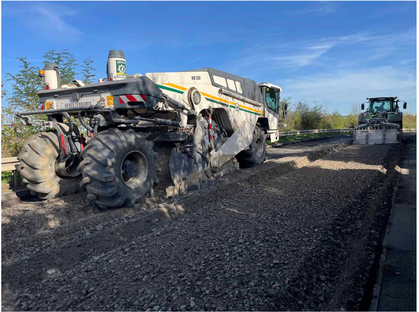
Sanierung der B27: Das Material der Straße wird vor Ort gebrochen und kann dann anschließend durch eine Stabilisierung mit NovoCrete wiederverwendet werden. Foto: pm
