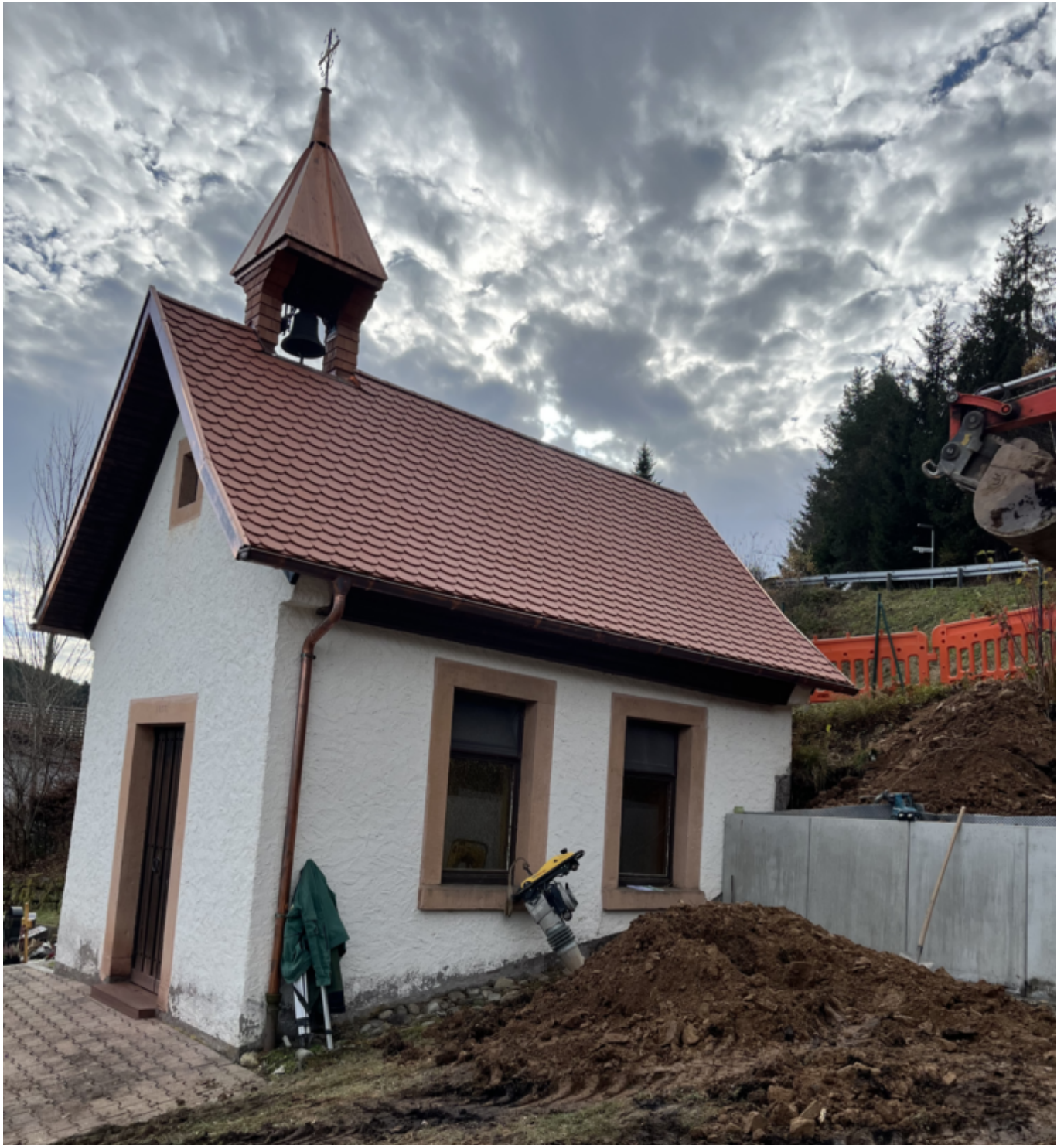
Hier bei der Aussegnungshalle wird die Urnenwand aufgestellt.
